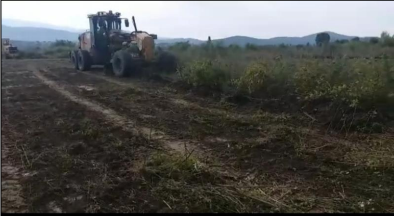
Şekil 3. Mera Islahı ve Amenajmanı Projeleri Kapsamında Yabancı ot ve Çalılıarın Temizliği
