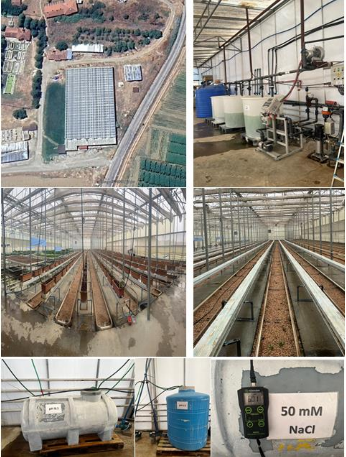
Şekil 3.1. Seradan genel görünüm, otomasyon, sulama sistemi ve uygulama tankları
