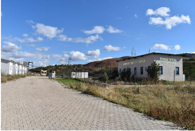
Şekil 2. 9. Kompost üretim tesisi (Orijinal,2024)
