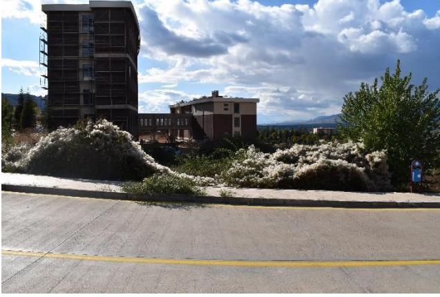
Şekil 2. 10. Yeni Rektörlük Binası İnşaata (Orijinal,2024)
